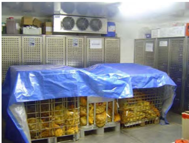
Abbildung 5: Kühlager im ttz Bremerhaven
