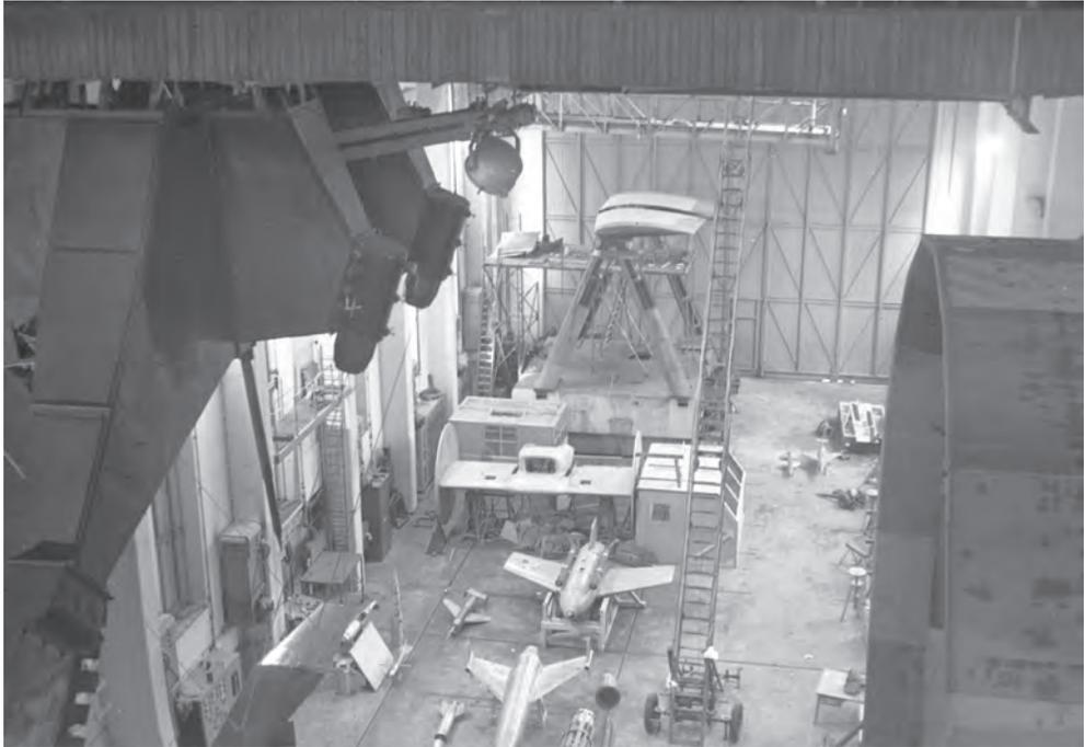
Abbildung 10: In dieser Innenaufnahme des Windkanals A3 sind gleich mehrere Modelle mit den charakteristischen Pfeilflügeln zu erkennen. Das Foto wurde von einer kanadischen Kommission aufgenommen, die das Gelände 1945 besuchte.
