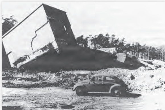
Abbildung 23: Trümmerräumung am gesprengten Hochgeschwindigkeitskanal A2.
