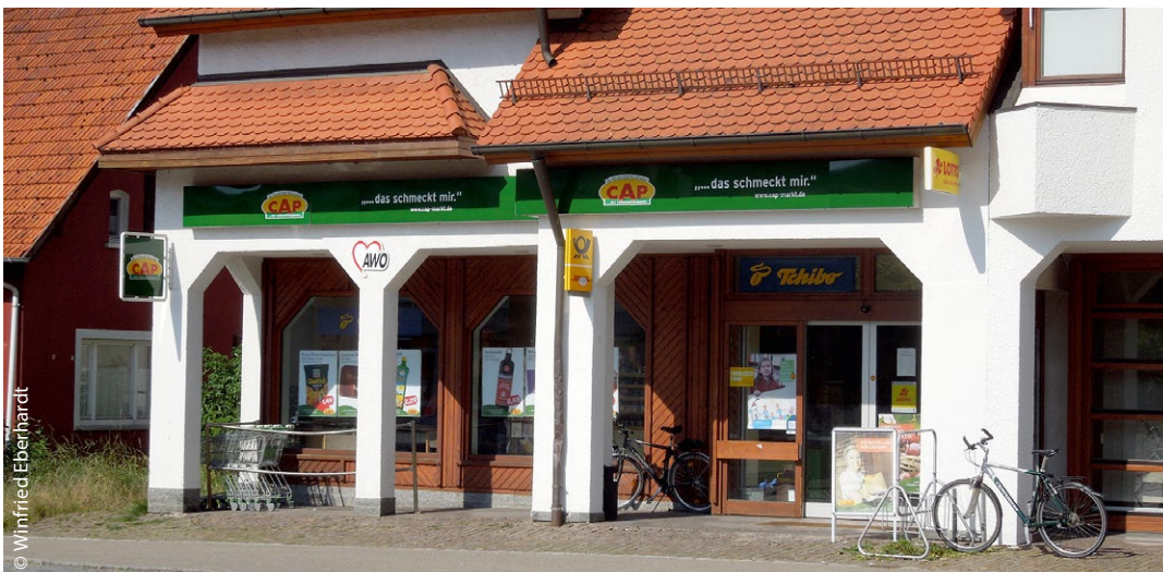
Gebäude eines CAP-Markts
