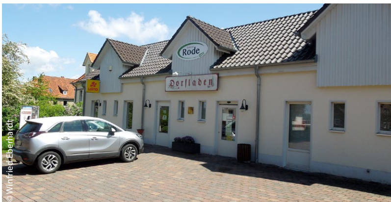
Dorfladen, der von einer Gemeinde betrieben wird
