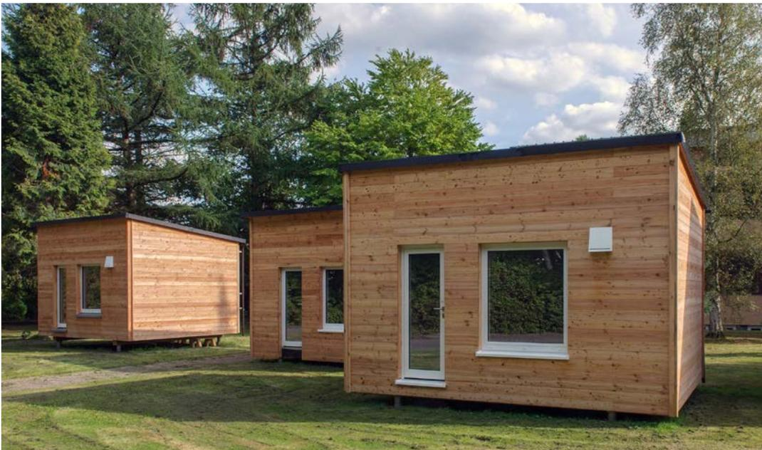
Modellhäuser mit unterschiedlicher Bauweise und Materialauswahl zur Untersuchung des Einflusses der verwendeten Holzbaustoffe auf die Raumluftqualität.
